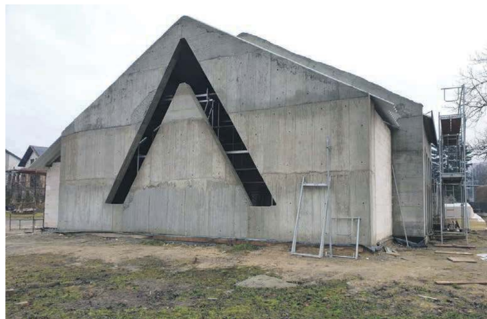
Widok budynku sakralnego od strony ul. Skorupki
