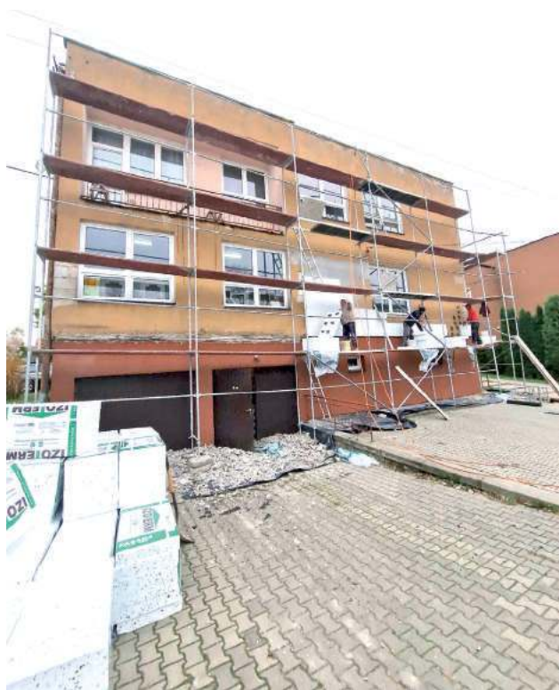
W Turobinie trwa rewitalizacja budynku miejscowego ośrodka zdrowia
