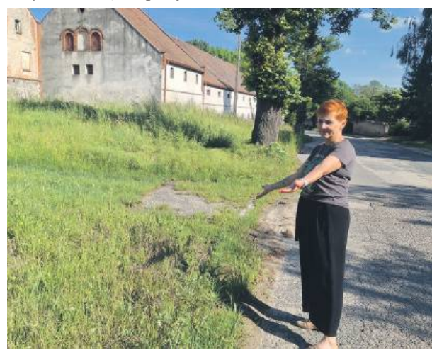
W niektórych miejscach chodnik jest zarosnięty
