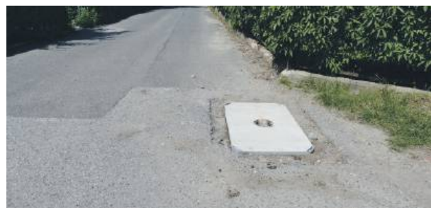
W czwartek, 6 czerwca, około południa monterzy Orange wstawili nową płytę
