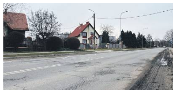
Planowany remont ul. Oławskiej w Strzelinie obejmie także remont chodników i jezdni aż do Chociwela
