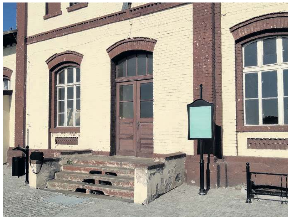
Wejście do świetlicy znajduje się z tyłu stacji
