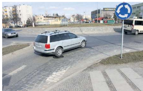
Zbyt mała przepustowość oraz źle ułożone przejścia dla pieszych to główne problemy strzelińskiego ronda
