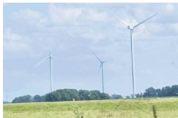
Przy samej granicy gminy Wiązów powstaje farma wiatraków (widać już kilka turbin). Zyski z tej inwestycji czerpać będzie jednak gmina Grodków. Dla mieszkańców wiazowskich wsi pozostaje tylko widok
