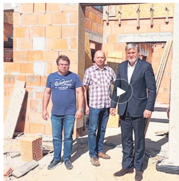
Jeszcze w tym roku w Brzezicy powstanie świetlica wiejska. Na zdjęciu Waldemar Grochowski, po prawej, a obok Leszek Ferenc i Jerzy Nowicki, pracownicy UG w Borowie
