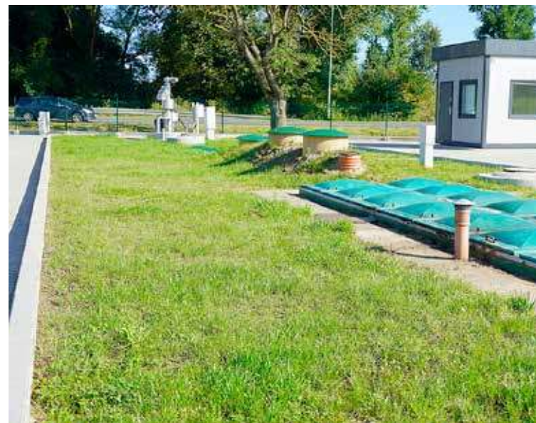
Oczyszczalnia w Słajfinie
