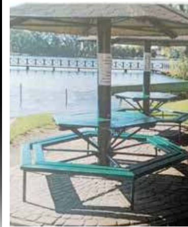
Prace odbyły się również przy tzw. grzybkach
