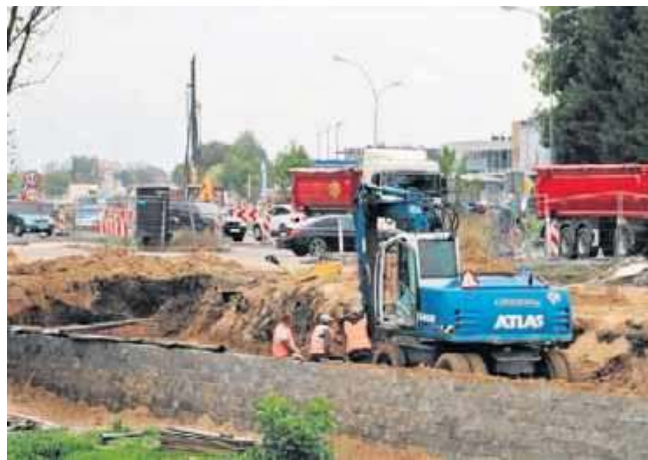
Budowa muru oporowego jest częścią przebudowy drogi krajowej nr 74 w Zamościu
