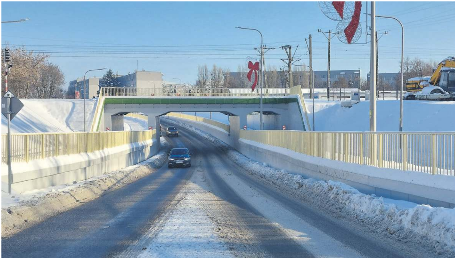
Budowa tunelu pod torami na linii kolejowej nr 68 była głównym celem zrealizowanego zadania. Bezkolizyjny przejazd łączy część mieszkalną miasta z tą biznesową, ze sklepami wielkopowierzchniowymi i punktami usługowymi
