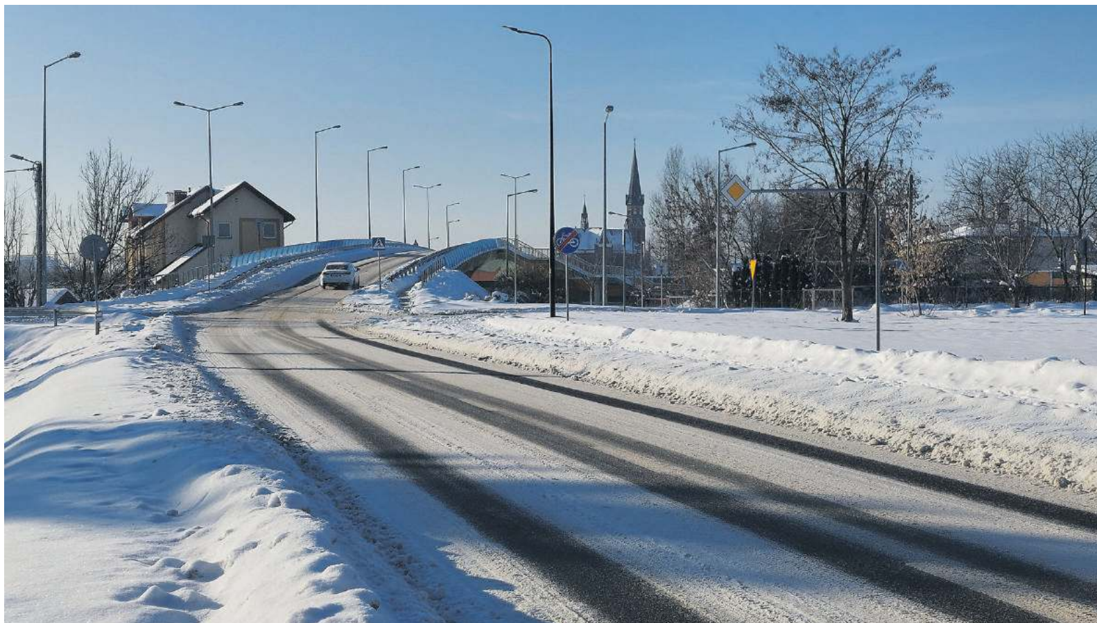
Ulicą Graniczną dojeżdżamy do ulicy Brandwickiej ulicami: Polną, Grochową i Karnaty. Na odcinku 1,8 km są 1,5-metrowe chodniki i 2-metrowe ścieżki rowerowe, wybudowano odwodnienie, a część terenu skanalizowano
