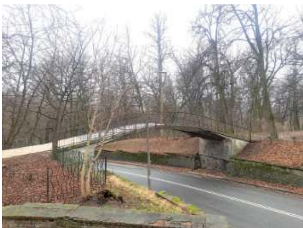
Kładka znajdująca się nad drogą wojewódzką nr 801 należy do miasta Puławy. Pieniądze z budżetu miasta mają trafić na wykonanie dokumentacji technicznej
