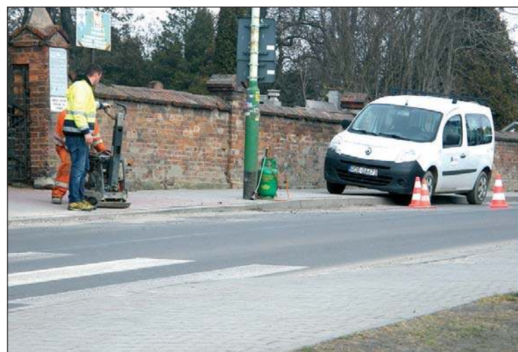
Przy Cmentarnej trwają prace. Na wiosnę planowane są kolejne.
