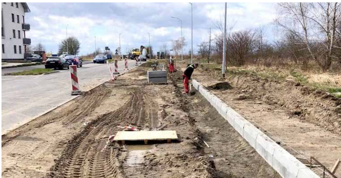
Na ulicy Pileckiego rozpoczęła się budowa chodnika z kostki betonowej, który będzie miał szerokość 2 m
