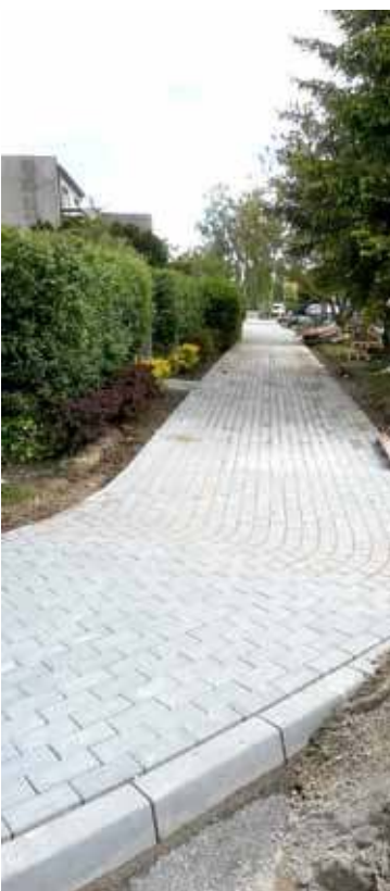
Piesi zyskają 350 metrów komfortowej nawierzchni z kostki
