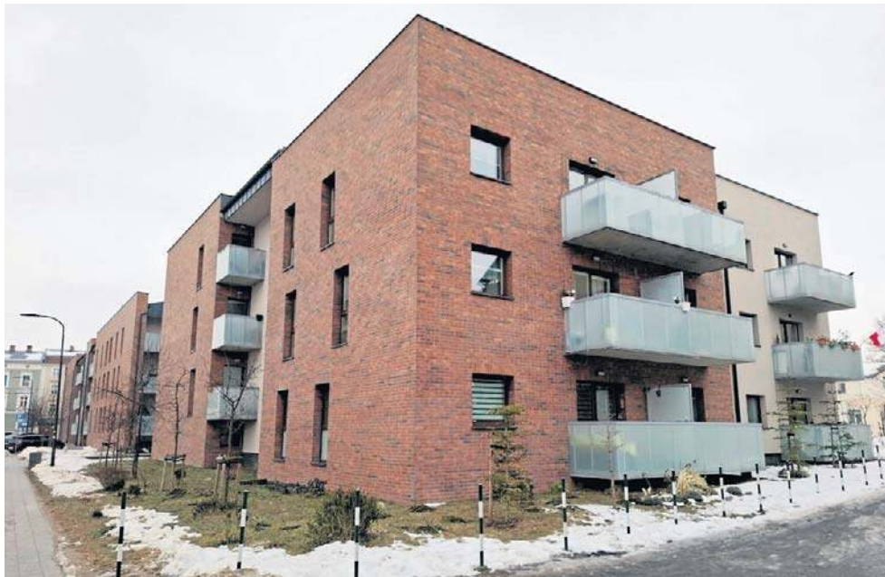
Budynek przy ul. Płowieckiej 1 wyróżnia się ciekawą architekturą, ale miłe dla oka wraźnie niknie po zapoznaniu się z listą usterek, które zgłaszają mieszkańcy
