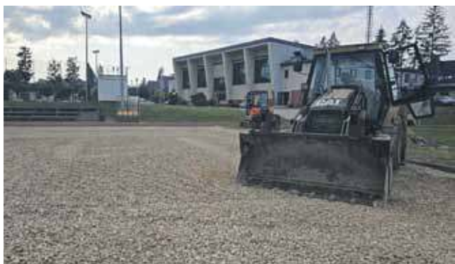
Trwa zmiana nawierzchni naturalnej na sztuczną na boisku przy KS Gorce w Nowym Targu.
