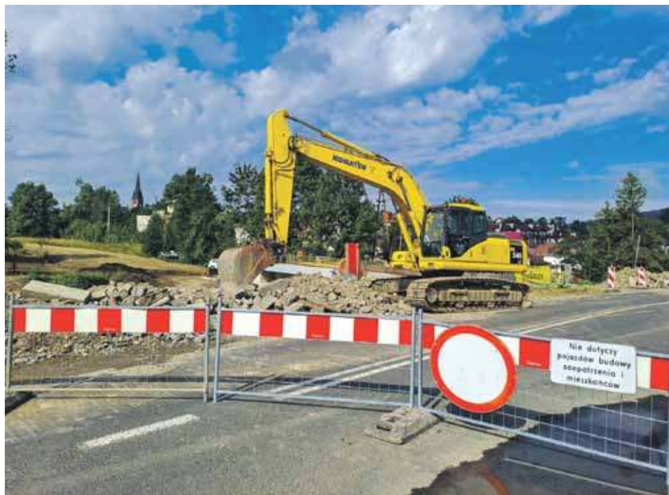
Prace na przejeździe potrwać blisko cztery miesiące.
