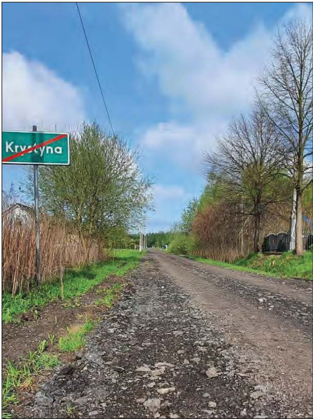
■ Odcinek drogi powiatowej, biegnącej przez Krystynę, został do ostatnich zabudowań przed lasem utwardzony destruktem asfaltowym
