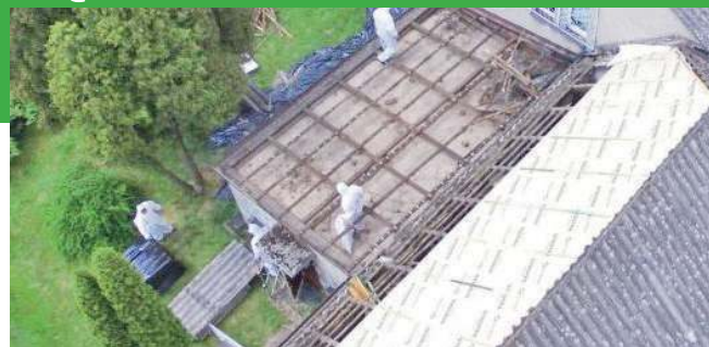
Dzięki środkom, o które będzie wnioskować miasto Pszów, mieszkańcy będą mogli nie tylko usunąć eternit, ale także odbudować dachy, jak miało to miejsce na domu działkowca w Rydułtowach (na zdjęciu)
