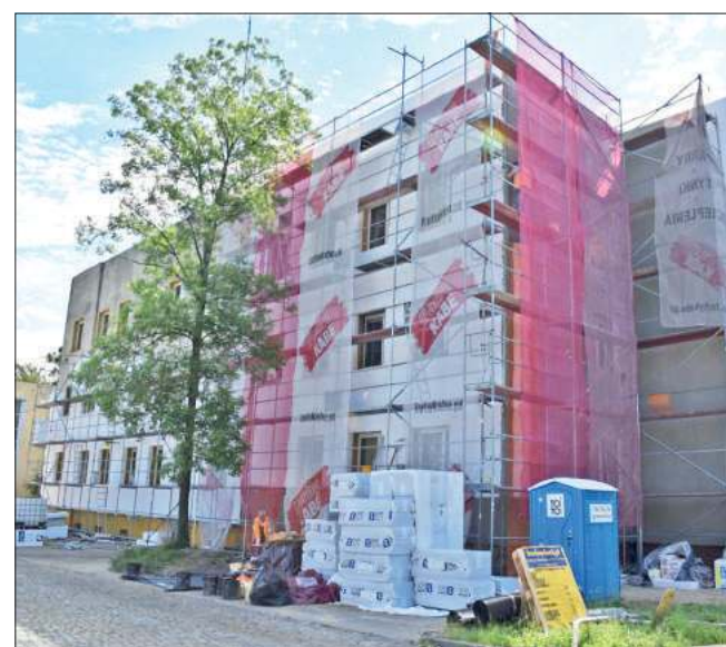
W ramach projektu zostaną przeprowadzone prace termomodernizacyjne ograniczające straty ciepła oraz podnoszące sprawność instalacji centralnego ogrzewania. Ekipa remontowo-budowlana remontuje już oddział pediatryczny w Rydułtowach.
