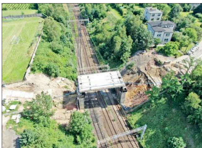
Budowlancy po przerwaniu prac i problemami wynikającymi z pandemii koronawirusa przystępuje ponownie do przebudowy wiaduktu. Miasto umowę z wykonawcą przedłużyło do końca roku.
