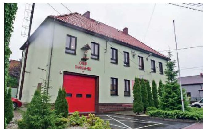
W domu gromadzkiem mieści się remiza OSP Turza Śl. Zostanie przeniesiona kilkaset metrów dalej, do domu sportu przy boisku Unii Turza.
