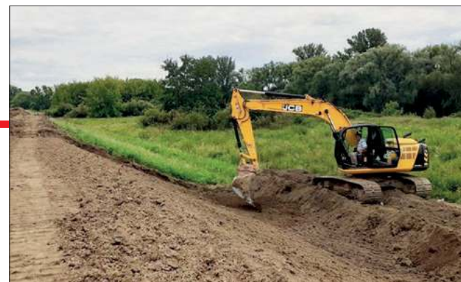
To pierwsza tak duża inwestycja przeciwpowodziowa w gminie Gorzycy od powodzi z 1997 r.
