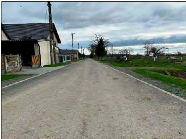
W 2023 roku przebudowano drogę w Pisarzowicach. Wartość zadania wyniosła 1 039 457,83 zł.
