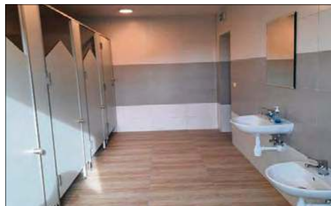
Modernizacja łazienki oraz sanitariatów w oddziale przedszkola w Dziedzicach kosztowała 80 000 zł.
