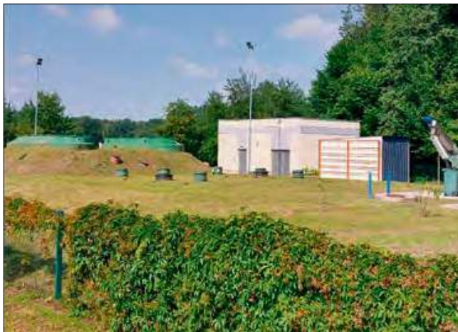
Modernizacja oczyszczalni ścieków w Mosznej. Inwestycja kosztowała 27 200 zł netto.
