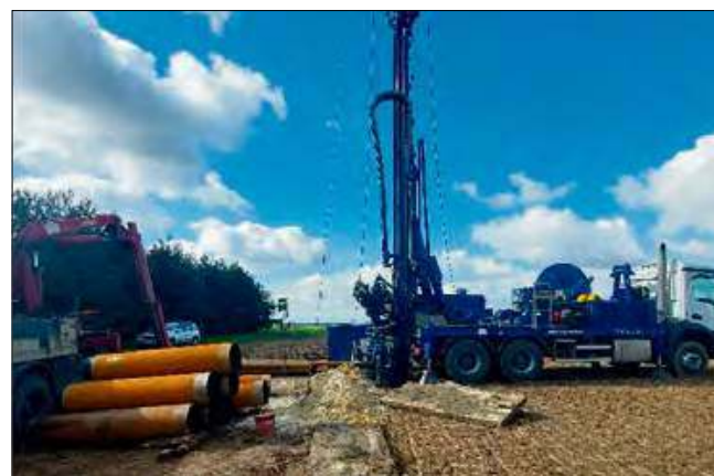
Budowa Stacji Uzdatniania Wody w Dziedzicach w zakresie wykonania II odwiertu studziennego wody. Wartość zadania wyniosła 986 914,03 zł.
