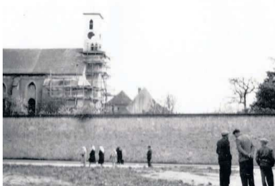
Kościół pw. Podwyższenia Krzyża Św. Odbudowa wysadzanej w powietrze wieży kościelnej. Foto: archiwum Józef Kazimierowicz
