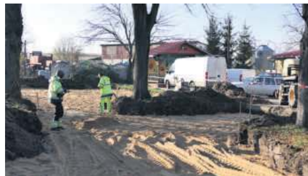
Parking przed świetlicą w Gęsińcu w trakcie budowy
