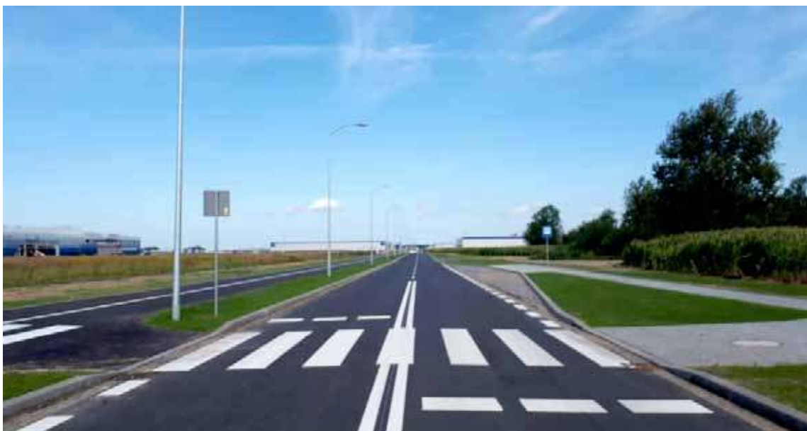
W ramach prac przedłużono ulicę Metalową, wykonano kanalizację oraz zamontowano oświetlenie
