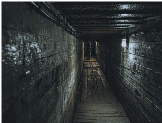
Podziemny tunel łączący dwa bunkry dowodzenia i łączności niemieckich wojsk lądowych
