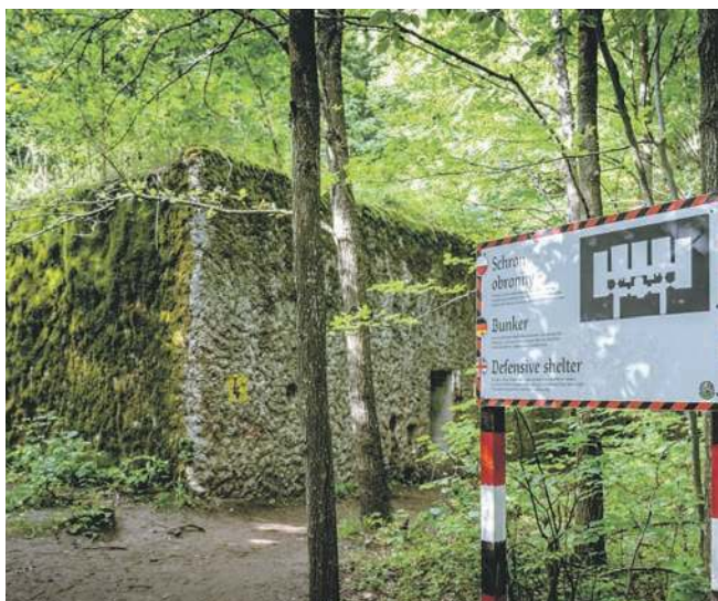
Struktura ścian sprzyja porastaniu naturalnej roślinności, co jest ogromnym atutem pod względem kamuflażu
