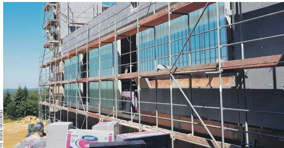
Budowa basenu rozpoczęła się dwa lata temu
