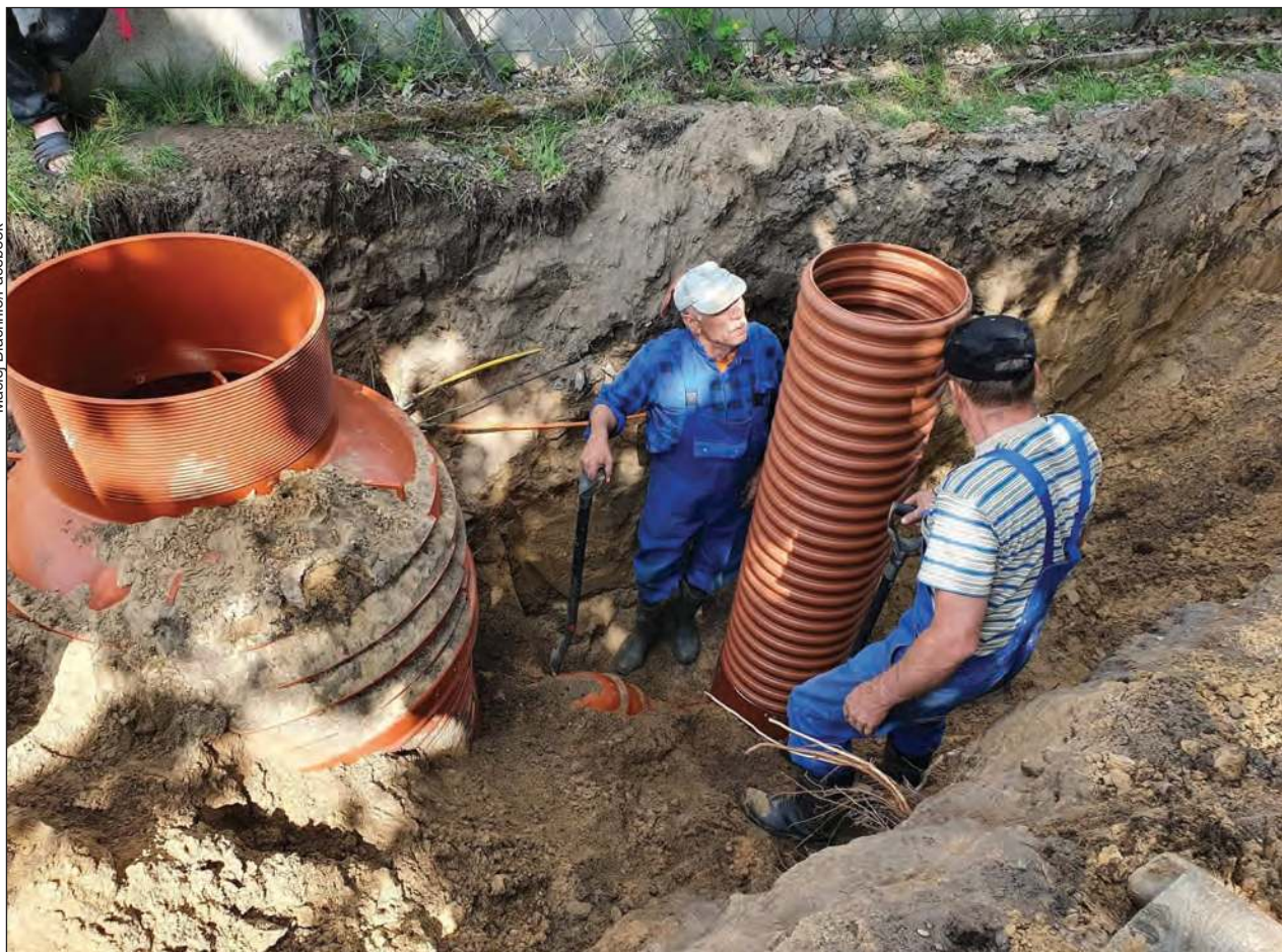
Przebudowę wodociągu i montaż studni rozprężnej na ul. Krótkiej prowadzą pracownicy referatu komunalnego
