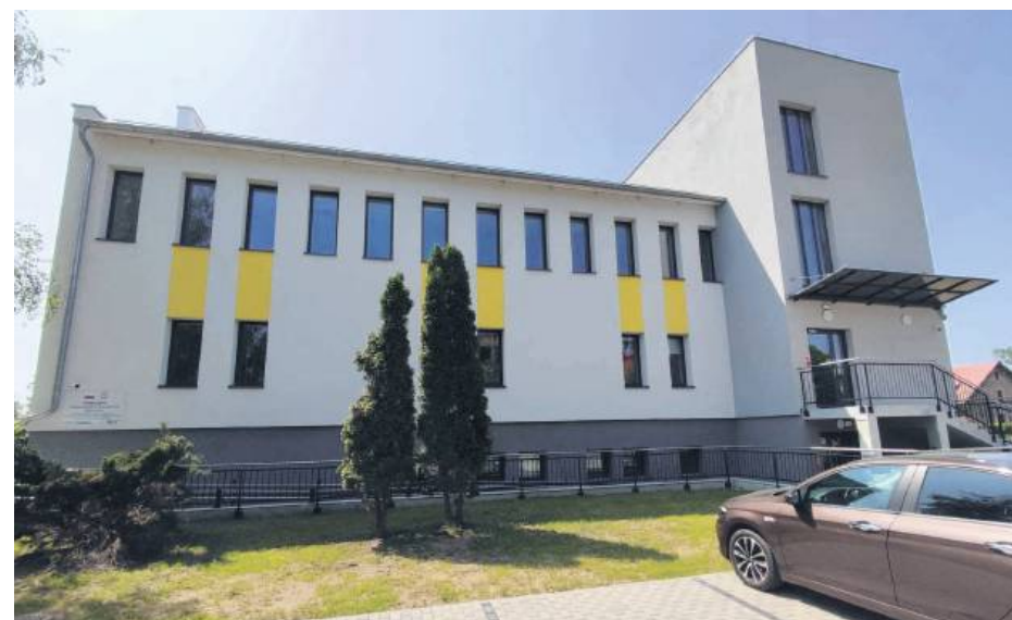
Estetyczny, wyglądający jak nowy budynek szkoły muzycznej przy ul. Pocztowej...
