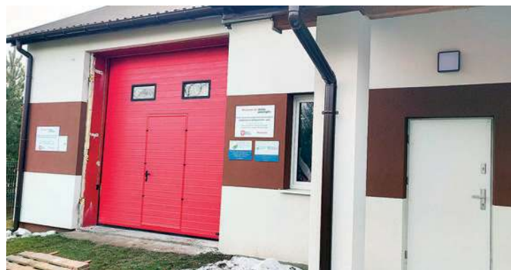
Modernizacji poddana została brama garażowa strażnicy
