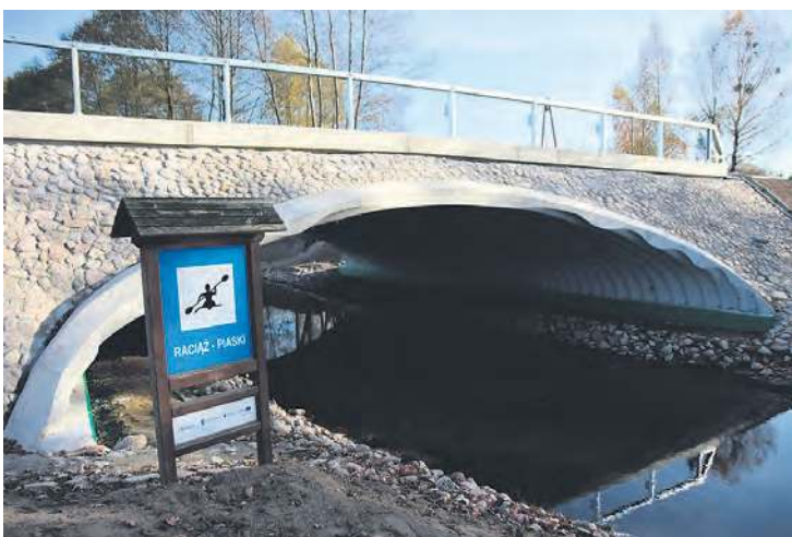
Zamiast drewnianego mamy solidny most o konstrukcji stalowej.
