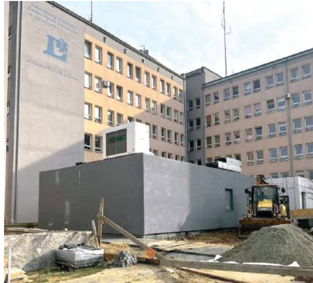
Obiekty przywiozły specjalne ciężarówki-platformy, na docelowe miejsce zostały posadowione przez dźwig
