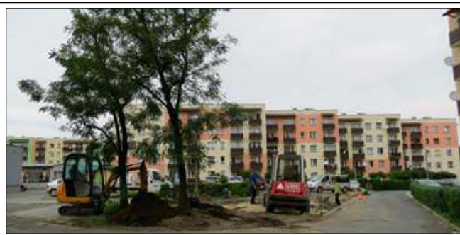
Budowa nowych miejsc do parkowania w miejscu wycinki oburzyła część mieszkańców osiedla.
