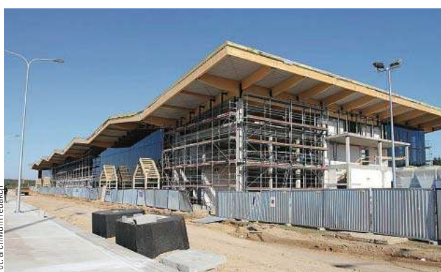
Budowa hali na lotnisku w Szymanach
