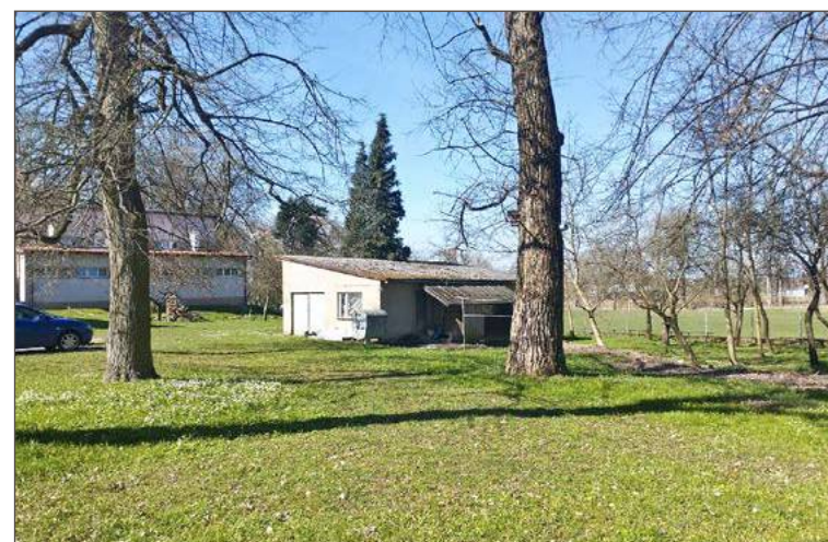
Stary budynek już został wyburzony.
