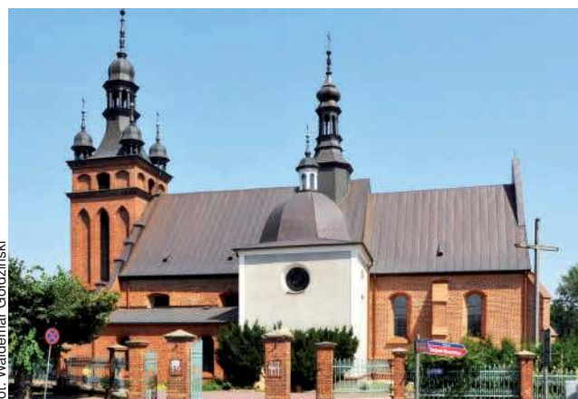
Dzięki dotacji samorządu Mazowsza wyremontowano elewację kaplicy Owadowskich w kościele pw. Podwyższenia Krzyża Świętego w Zwoleniu
