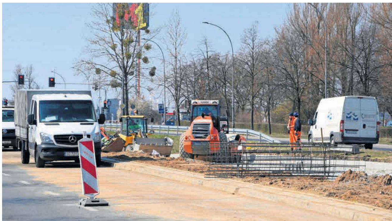
W Częstochowie kontynuowana jest modernizacja linii tramwajowej. Prace poszerzyły się o kolejną dzielnicę, przez którą przebiega infrastruktura tramwajowa. W dzielnicy Tysiąclecie, na pętli przy ul. Kiedrzyńskiej, rozpoczęły się prace rozbiórkowe. Plac budowy został odpowiednio wygradzony. Z tego powodu al. Armii Krajowej została zwężona o jeden pas.
