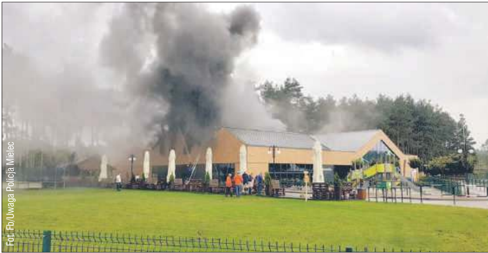
Pożar zajął salę bankietową Lubaszka w kompleksie Rado.
