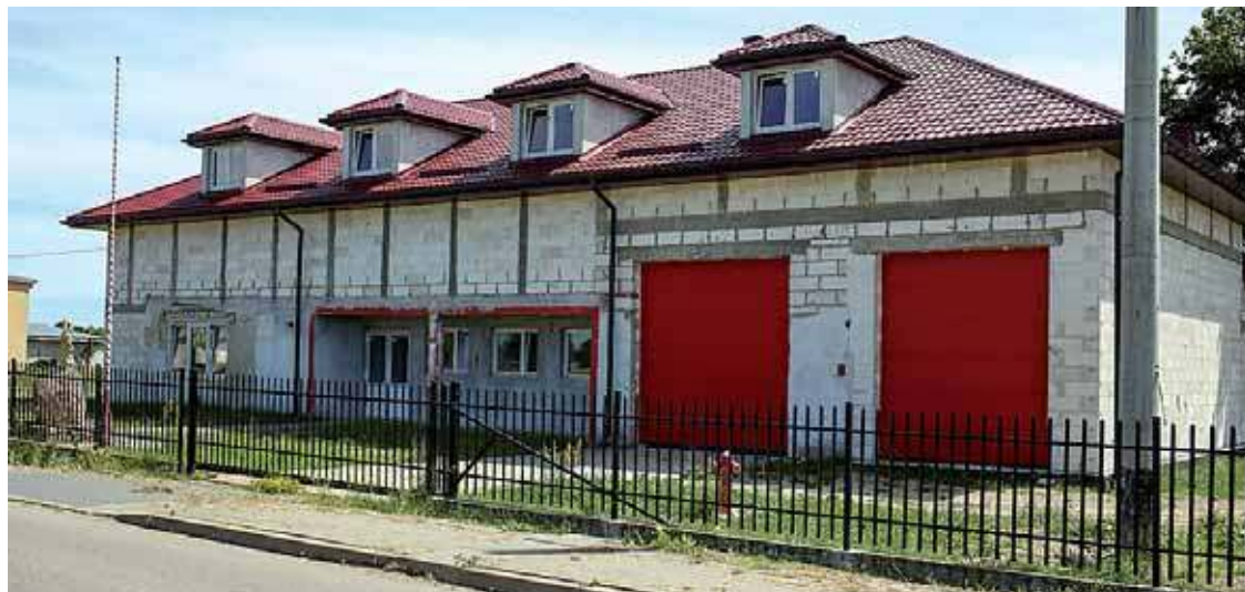
Wiejski dom kultury w Bądkowie, który ma być jednocześnie remizą OSP, pewnie jeszcze długo poczeka na dokończenie
