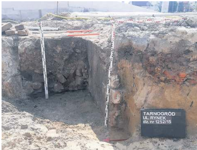
Podczas prac natrafiono na olbrzymie fundamenty.
