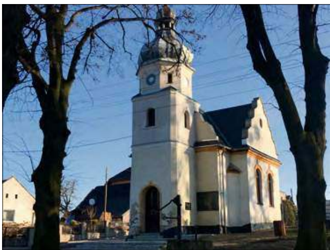
Do Oleszki trafi niepełna pół miliona złotych na renowację kaplicy.
