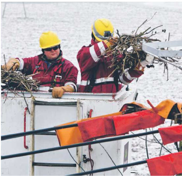
Zainstalowanie podestu wynosi gniazdo ku górze, zabezpieczając jego mieszkańców przed kontaktem z linią energetyczną | fot. mat. pras./d
