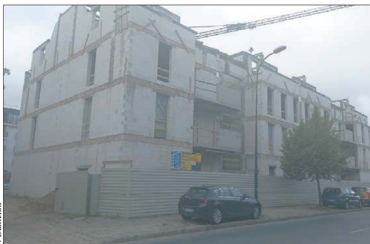
Trwa budowa bloku przy ul. Sienkiewicza 21
