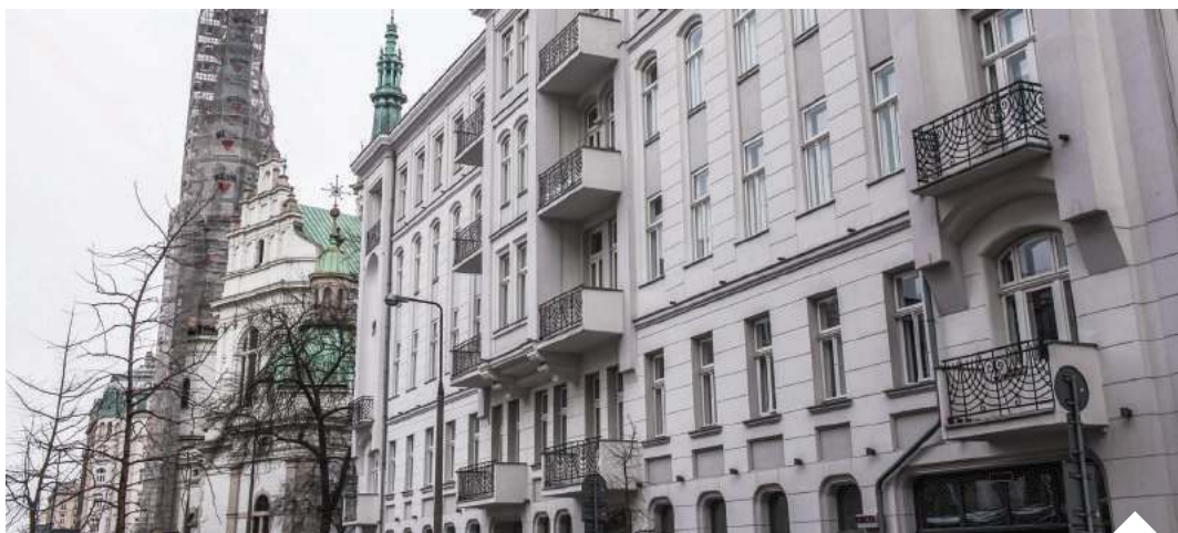
Niegdyś z kamienicy prz ul. Mokotowskiej 8 wyrzucono lokatorów i stworzono luksusowe apartamenty | fot. Filip Błażejowski/Gazeta Polska
