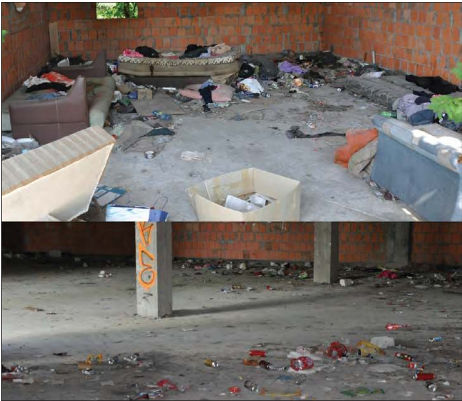
✚ Tak wygląda wnętrze opuszczonego domu
