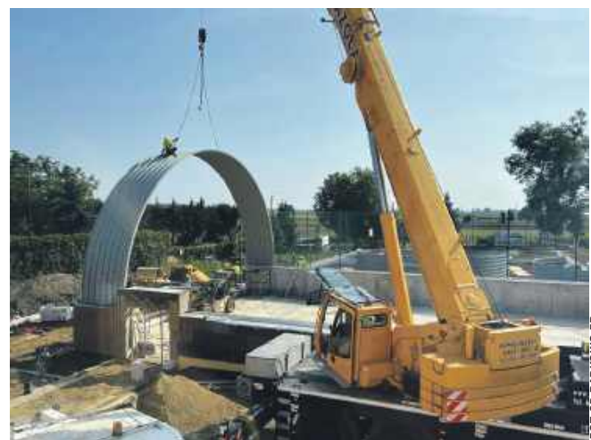
W Barkowie trwa budowa hali sportowej
