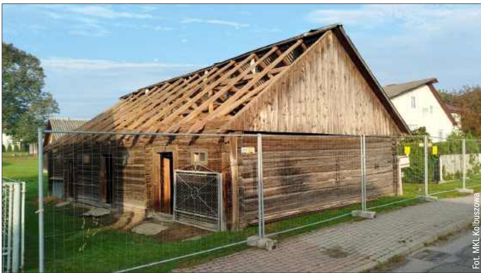
Po konserwacji stajnia trafi do skansenu.
