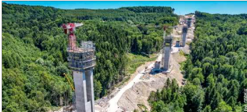
80-metrowa estakada poprowadzi w kierunku Bieszczad.
