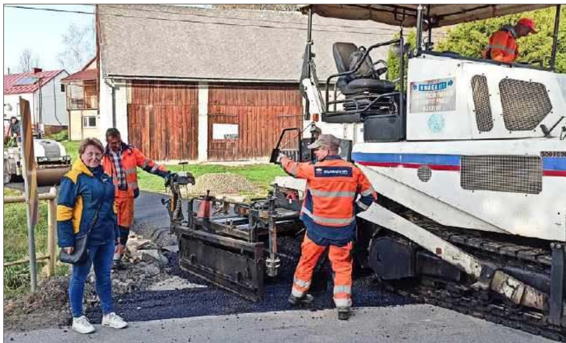
Prace w Jodłowej Górnej za szkołą dobiegły końca. Na zdjęciu sołtys i jednocześnie radna Elżbieta Łępa wraz z pracownikami firmy Eurovia przy remonтовanym odcinku.
