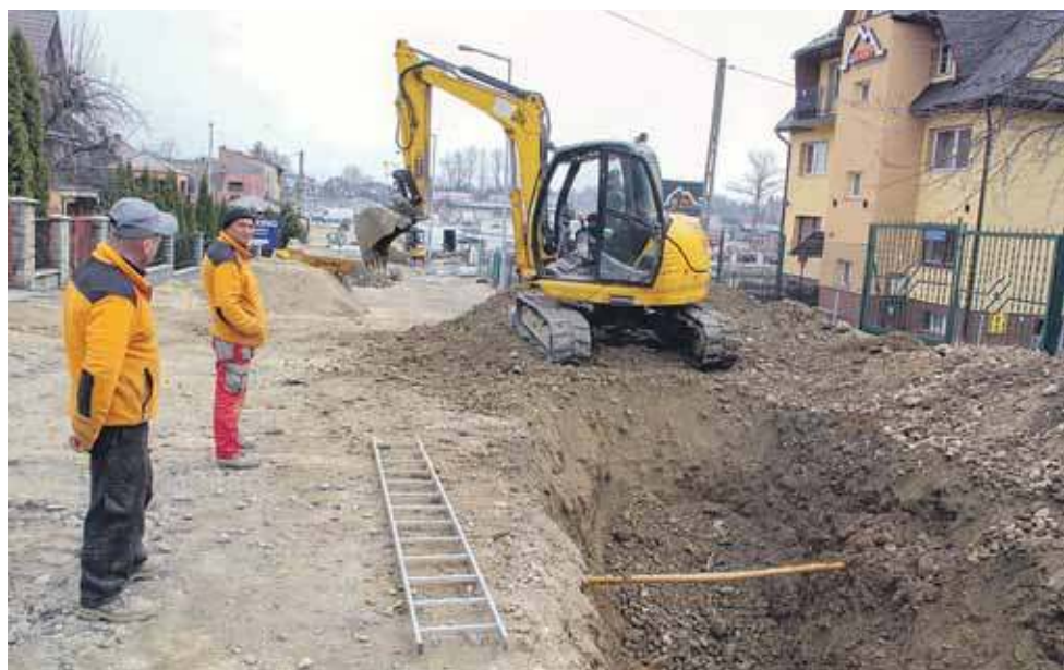
Remont Ogrodowej potrwa do końca lipca.
