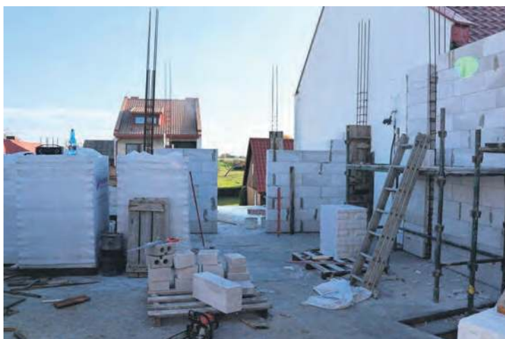
Budowa ma się zakończyć w czerwcu przyszłego roku.
