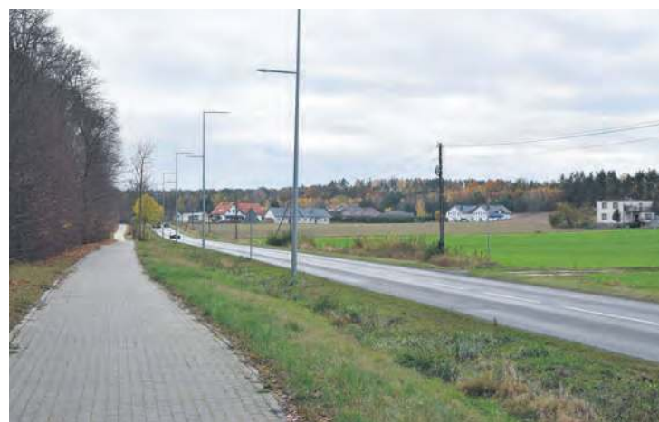
Trakt Przy Szosie Bydgoskiej jest popularny wśród zwolenników rowerowych przejazdów. Dla mieszkających po sąsiedzku to po prostu chodnik prowadzący do centrum miasta.
