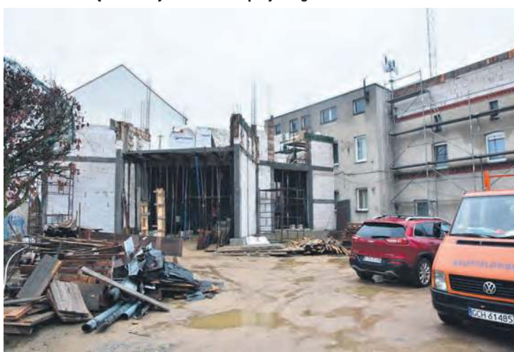
Od strony parkingu widać już, jak będzie wyglądało nowe wejście.
