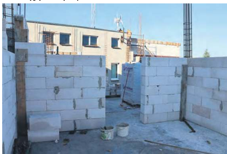
Na piętrze powstaną kolejne pomieszczenia.
