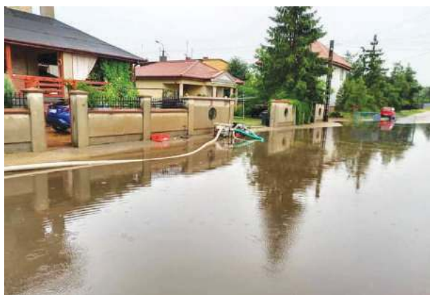
Na początku grudnia mają się rozpocząć prace, które rozwiążą problem zalewania ulicy Sosnowej
