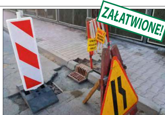
23 marca – przebudowa kanalizacji deszczowej w Górażdżach.
