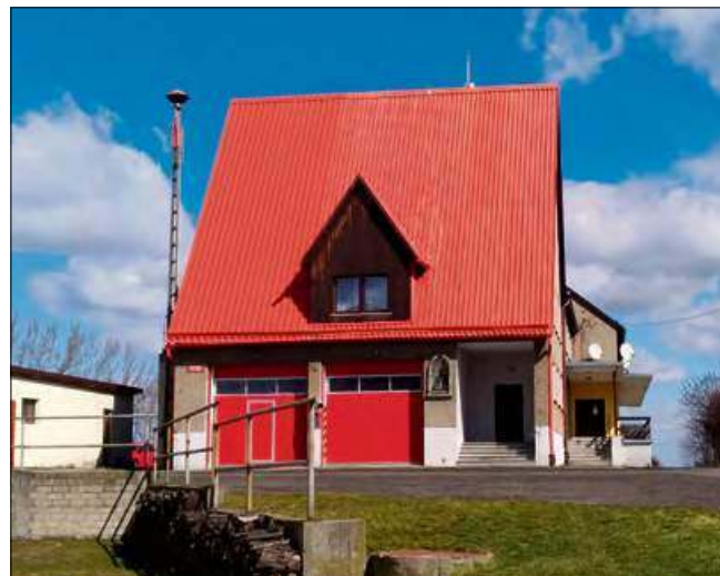
Tak prezentuje się budynek po remoncie.
