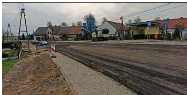
Drogowcy rozbierają dotychczasową nawierzchnię.
