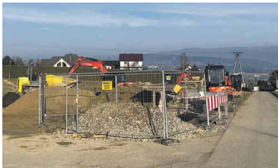
Prace przy budowie sieci gazowniczej mocno przyspieszyły.
