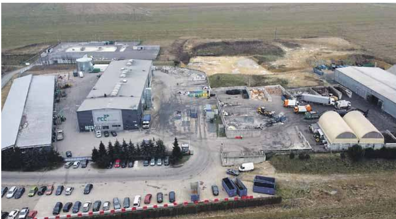
Sortownia śmieci w Nowym Targu. - Nie ma mowy, by mogła tu powstać spalarnia odpadów - przekonuje burmistrz.
