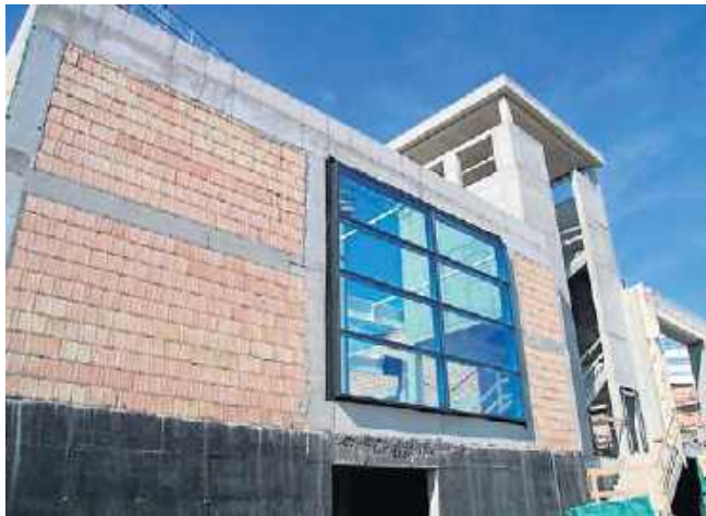
Basen w Jędrzejowie rośnie w oczach. Część okien została już zamontowana.
