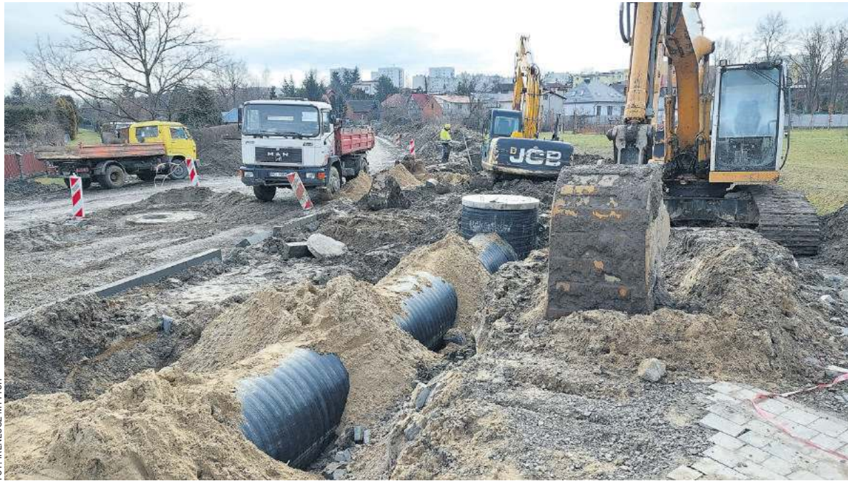
Modernizacja ulicy Działkowej w Stalowej Woli realizowana jest przy udziale środków z Rządowego Funduszu Rozwoju Dróg
