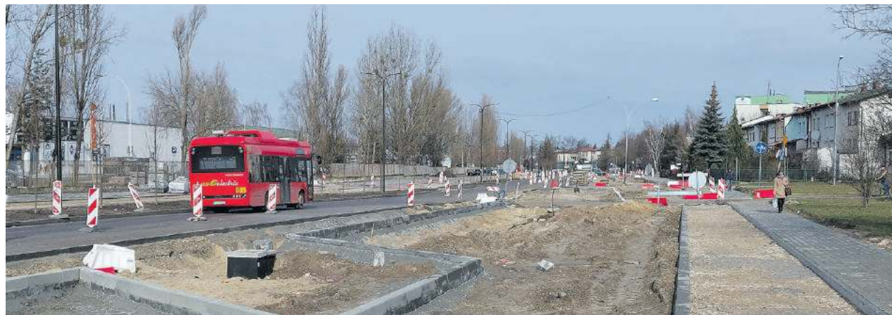
Miasto przy okazji modernizacji ulicy Okulickiego chce przy pomocy zbiorników retencyjnych uporać się z problemem zalewania tej drogi
