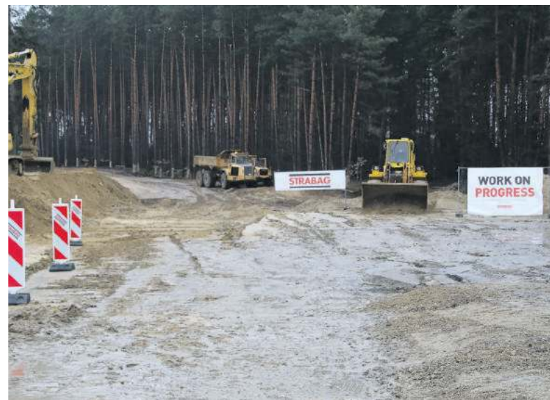
Wykonawca zadania, czyli firma Strabag, remont obu odcinków chce połączyć i zakończyć jeszcze w tym roku
