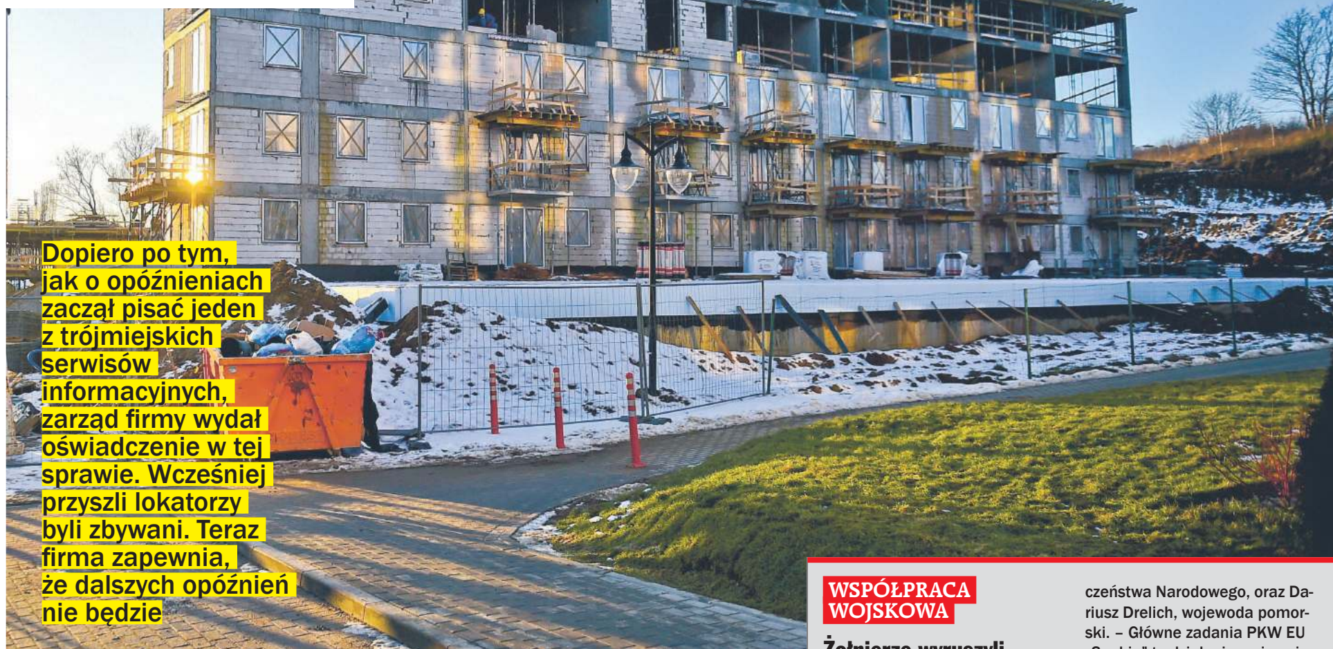
Bloki budowane na osiedlu Lawendowe Wzgórze | fot. Fotomag/Gazeta Polska
