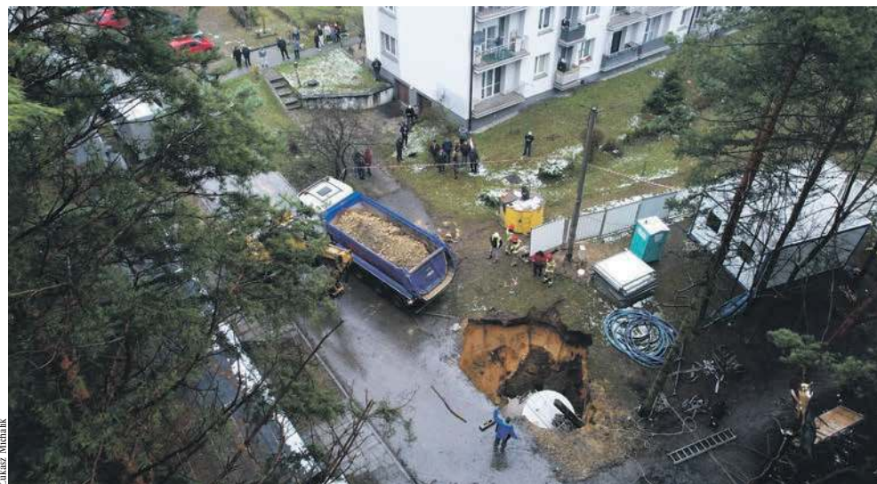
Zapadlisko przy bloku nr 26 w Gaju
