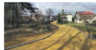
Powstający łącznik między istniejącą ścieżką rowerową a ul. Gieryskiego na osiedlu Kąty w Chrzanowie
